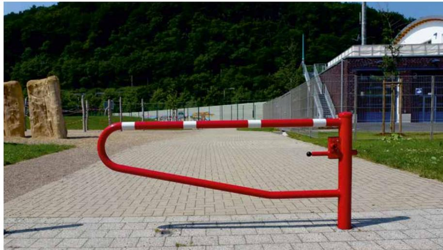
**Drehpfosten:** Stahlrohr Ø 102 mm,
