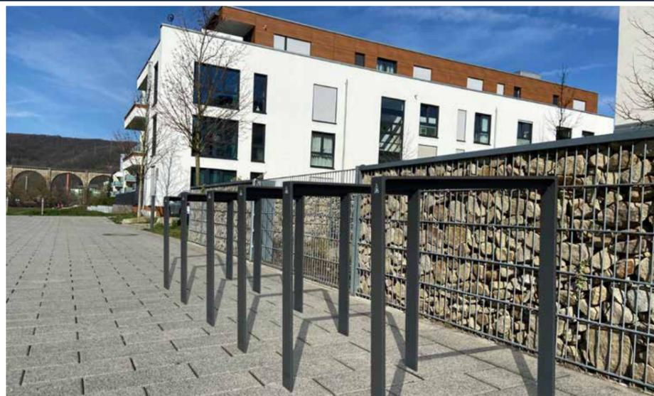
**Flachstahl 80 x 12 mm ohne Querholm zum Einbetonieren**
