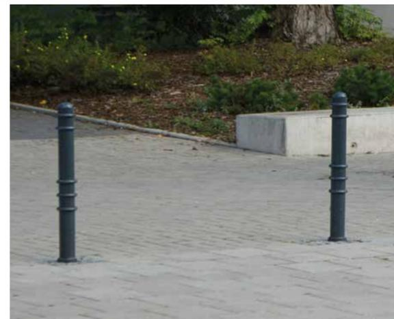
**Absperr-Stilpfosten** aus Stahlrohr, Ø 76 mm, ca. 950 mm Überflur, feuerverzinkt und beschichtet
