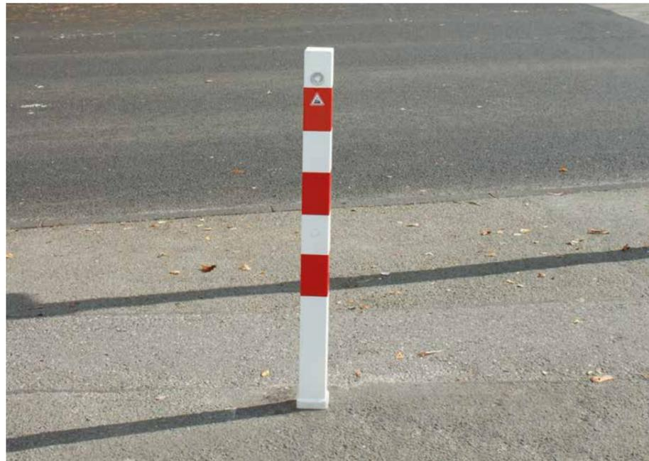
herausnehmbar mit Dreikantverschluss nach DIN 3223,
